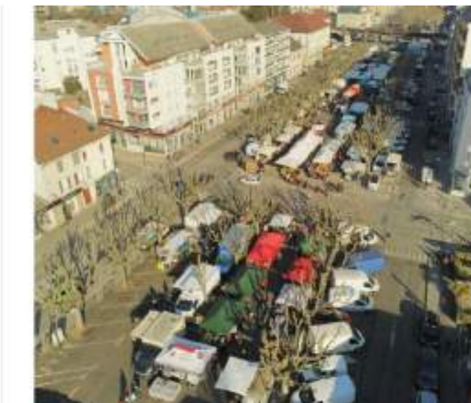
Promenade du Mail Voiron 5000 m2 Travaux en cours
