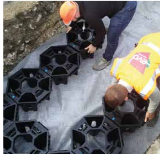
Mise en place des cellules sur du bidime pour retenir les modules.
