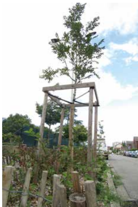
Tuteurage quadripode en zone de stationnement, natte de bambous fendus, Pied d'arbre végétalisé, rue Alfred Gaymard, Saint-Martin-d'Hères.
